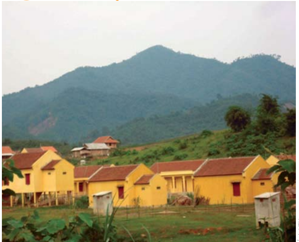
Nhà ở xuống cấp tại khu tái định cư Bản Vẽ
