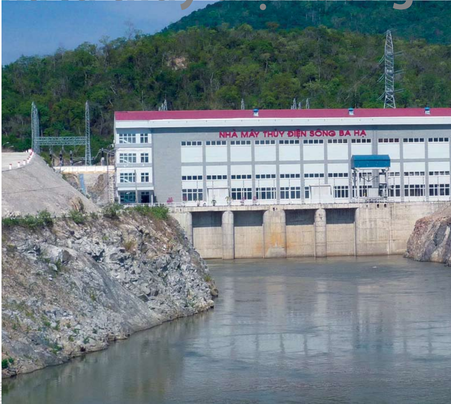
Thủy điện Ba Hạ
